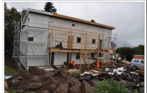
«Svingen». Det jobbes på spreng og de 8 leilighetene ved siden av Hamarøys Internasjonale Senter er snart klare for innflytting.
